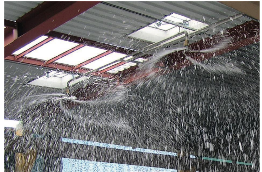
Rotor One Seven do powierzchniowego podawania piany sprężonej One Seven
