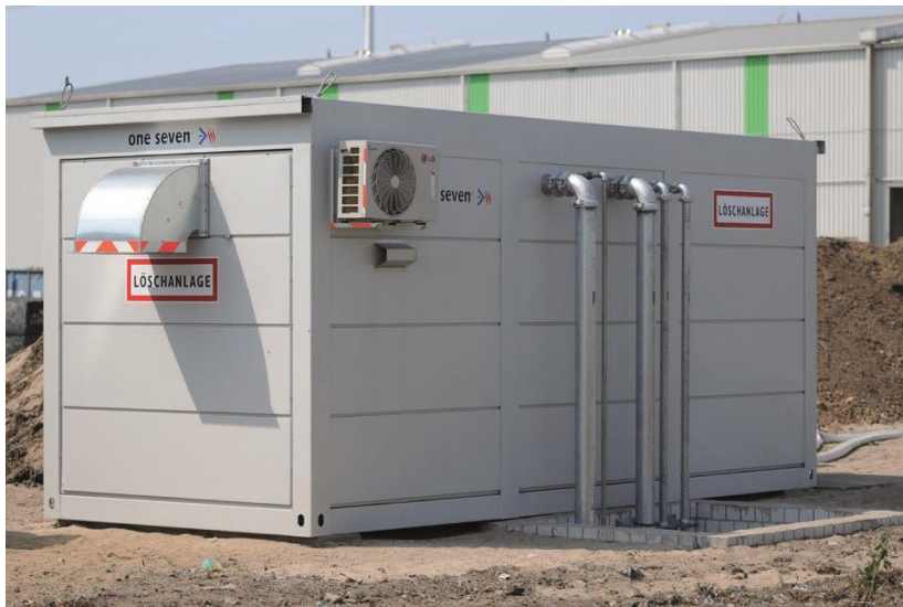
Kontener 20` z kluczowymi elementami systemu gaśniczego One Seven
